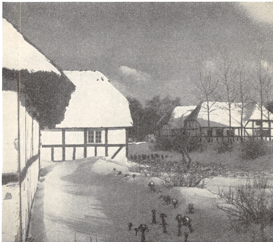
Frilandsmuseets fynske bygninger i sne. Til venstre gård fra Lundager. I den frem-springende fløj findes gårdens storstue. Tilhøjre trelænget husmandshus fra Arup. Begge bygninger typisk fynsk bindingsværk fra midten af 1700-tallet.
