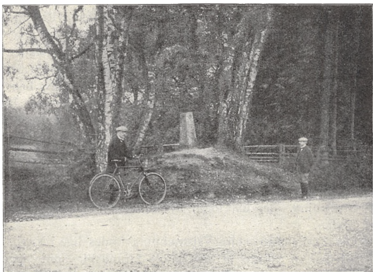
Fig. 3. Milesten fra Ole Rømers Opmaaling af Vejene. Ved Egelund, mellem Hillerød og Fredensborg.
