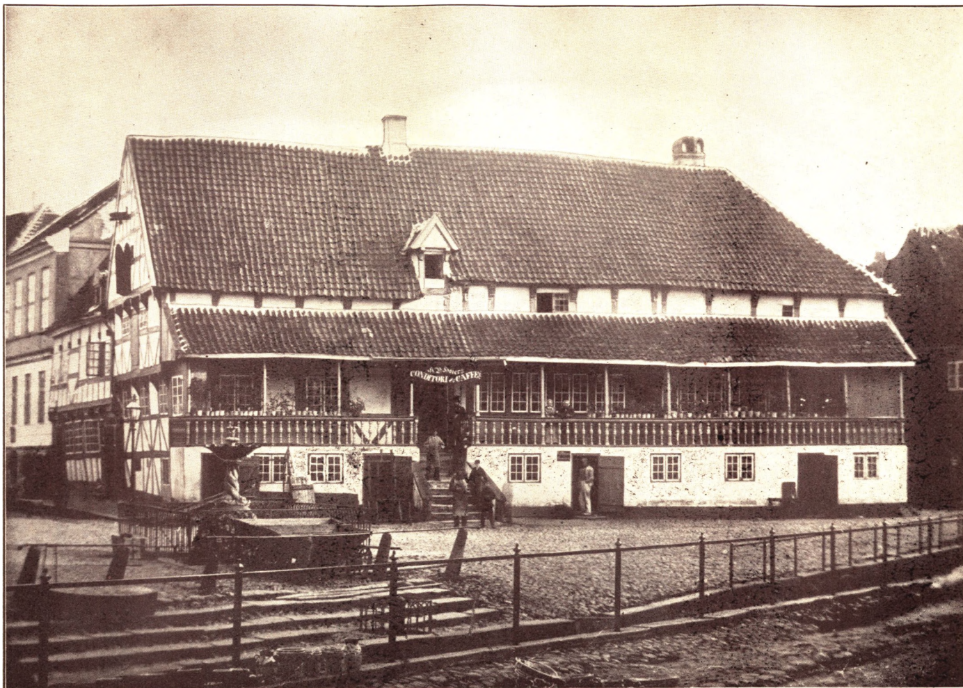
»Svalehuset« — hvor nu Aalborg Bys og Omegns Sparekasse ligger.
