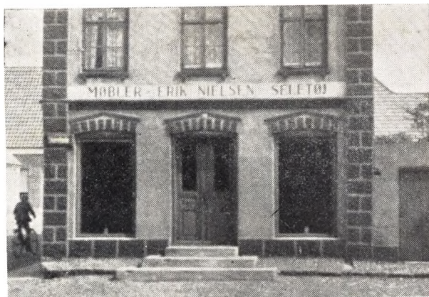
Sadelmagemester Erik Nielsens Ejendom før Ombygning
