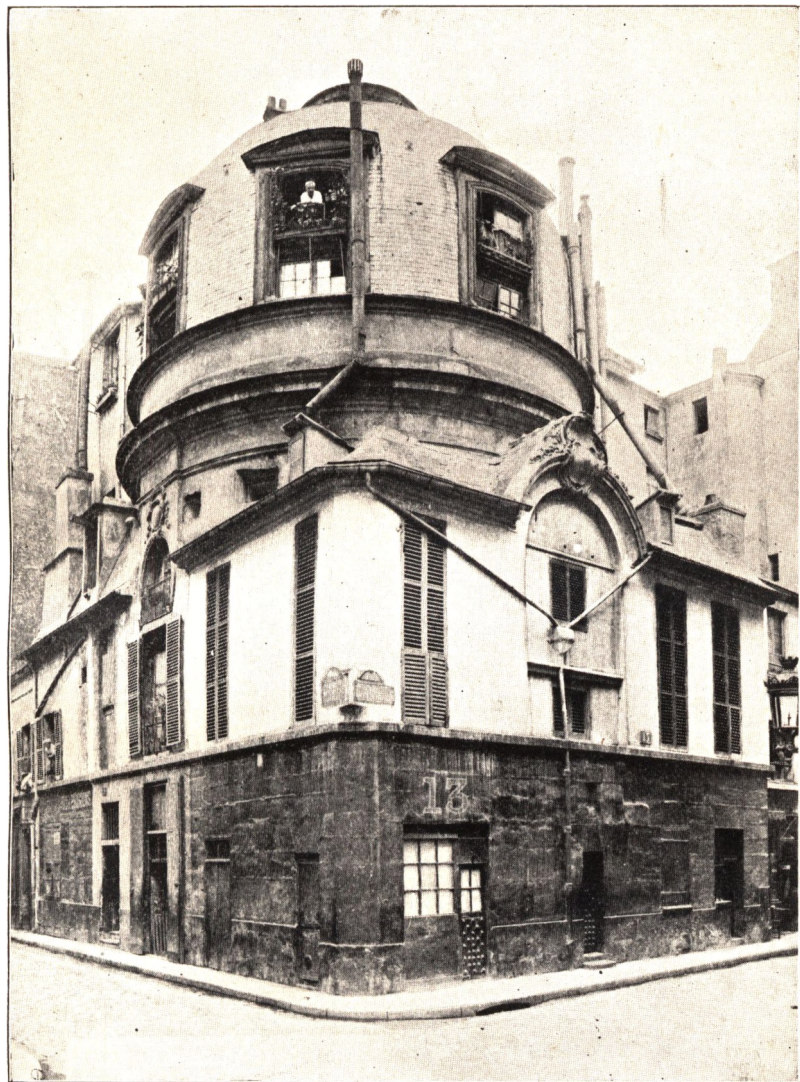
Det af Winsløv indviede amfiteater i Paris før restaureringen. Sét fra gaden.
