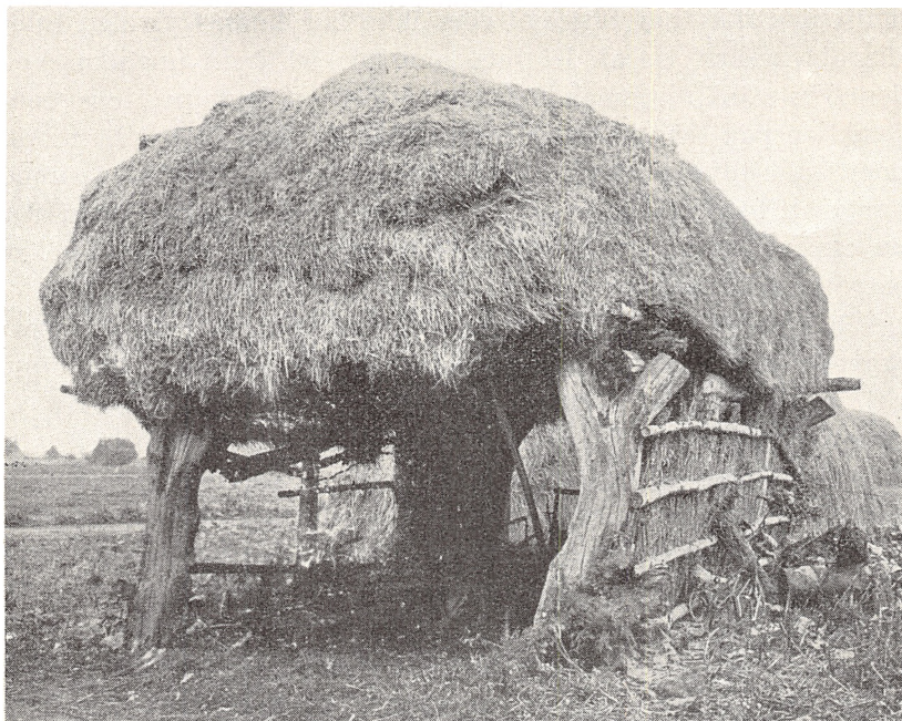
Fig. 1. Havrebod fra Teglstrup, Baarse h., Præstø amt. (K. Uldall fot.). Taget bæres af fire jordgravede stolper, der foroven ender i naturgroede tvejer. I tvejerne ligger to tagremme. Mellem disse er der lagt bjælker, hvorpaa halmen ligger. I ældre tid anvendtes disse boder til at opbevare den utærskede havre til hestene paa. Her laa det i fred for mus o. lign., nedenunder havde man samtidigt redskabsskur.
