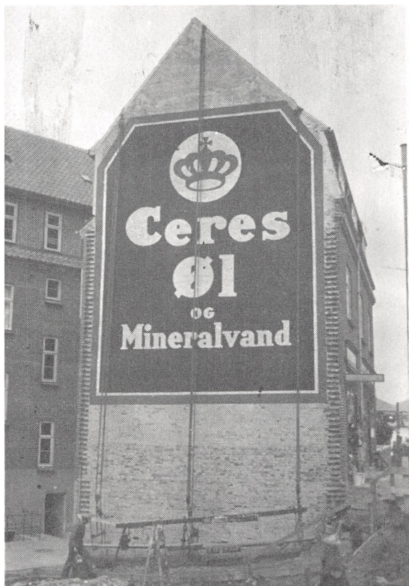
På en gavl ved viadukten i Viby er skiltemalerne i færd med at lave en Ceres-reklame. Billedet viser, hvor primitivt skiltemalerne arbejdede. De stod blot på et bræt, der hang i tre tove på muren. I dag skal der benyttes faste stilladser. (Foto i privat eje).
