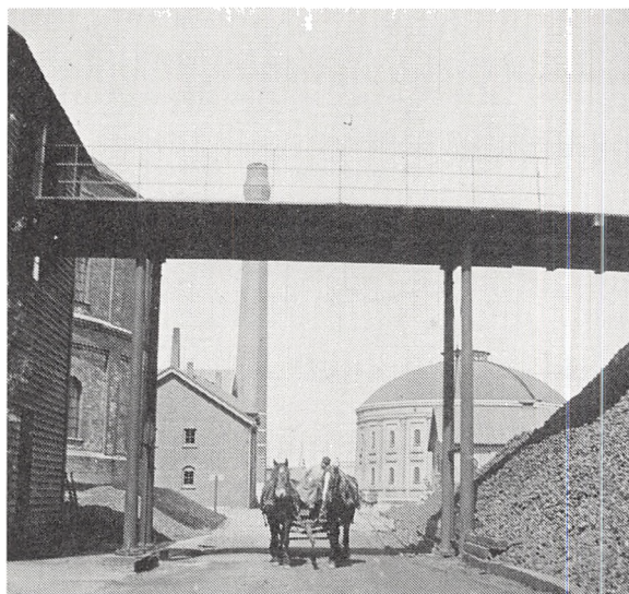
Her ses i baggrunden en gasbeholder opført i 1895 på et opdæmmede areal. Den runde bygning er typisk for sin tid med de høje afrundede vinduer i de fint markerede felter; inde i bygningen var der en jernklokke, der svømmede i vand og rummede gassen. (Foto i Lokalthistorisk Samling).
