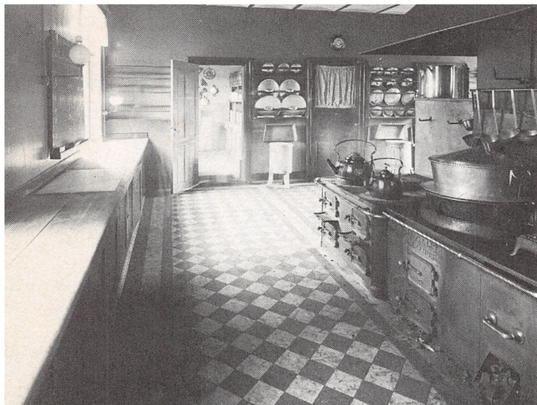
Fra dette store komfur blev maden leveret til patienterne på Kommunehospitalet ved århundredskiftet. Det var indrettet efter de mest moderne principper, og der var såkaldte »ringhuller« i den svære støbte plade, så der kunne koges med dybe, store kar. De store institutionskomfurer var i øvrigt ofte lavet efter mål, og almindeligvis var de, som her, omgivet af et messinggælender.
