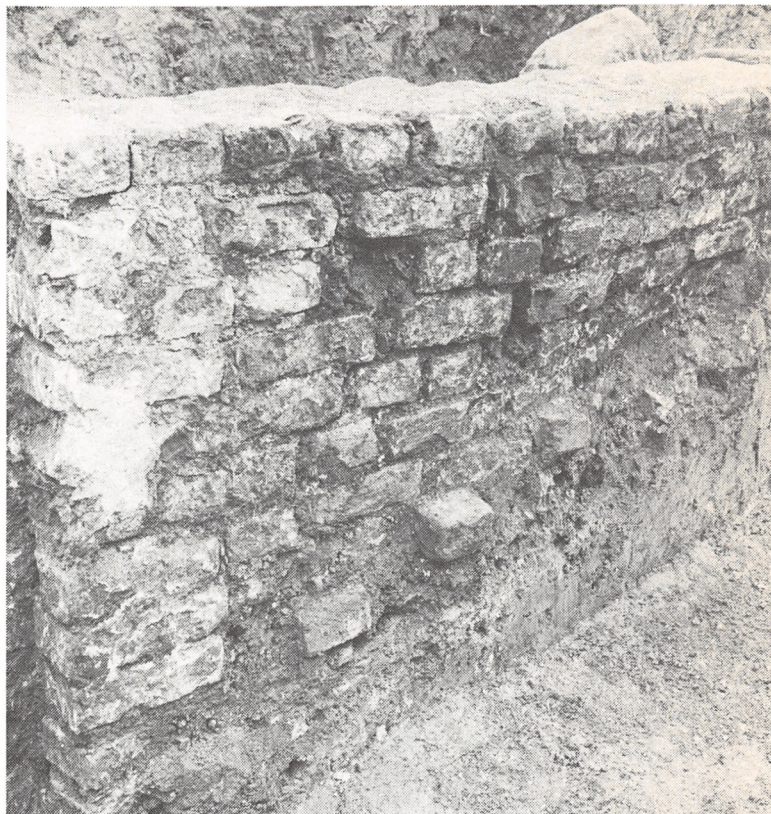
Munkestensmuret væg i kældernedgangen fra gården. Stenene er sat i »krydsskifte«, en muringsteknik, der først kendes fra ca. 1550.
