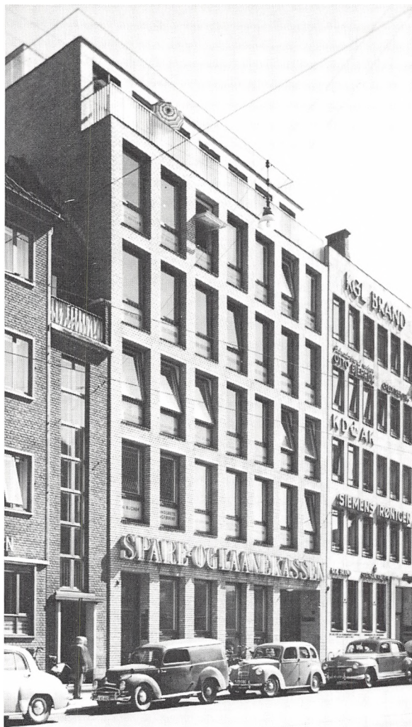
Spar- & Laanekassen, Store Torv, Århus, opført 1950-51. (Foto i Lokalhistorisk Samling).
