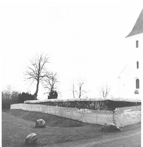
Kampestensmuren og voldgraven på vestsiden af Malling kirkegård. Muren var i middelalderen væsentligt højere, end den ses i dag. Reparationen vil formentlig være færdig i løbet af 1988.
