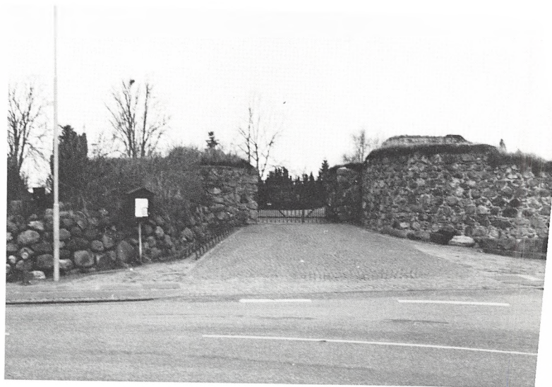
Rester af middelalderens fæstningstårn ved indgangen til kirkegården i Malling.
