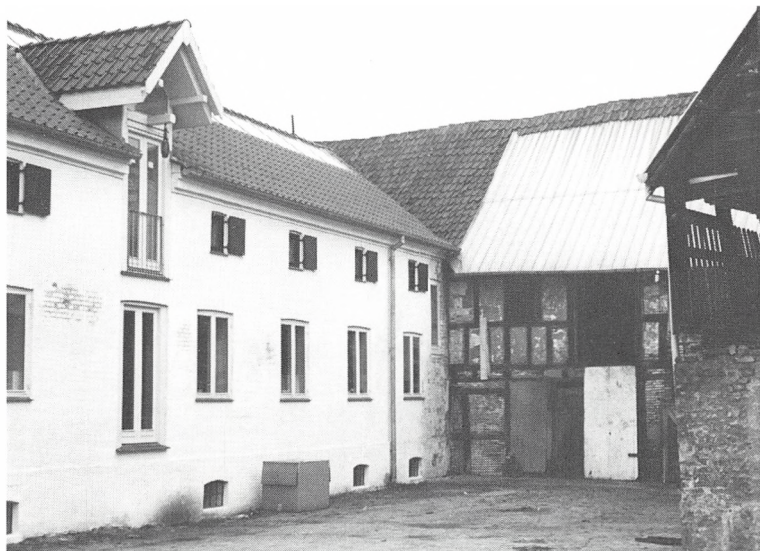
Her ses tydeligt, hvordan det istandsatte pakhuse er bygget ind på sidehuset. Yderst til højre forhuset med svalegang. (Foto i privateje).
