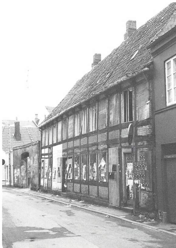
Graven 3, forhuset, set mod Mejlgade. Ejendommens miserable tilstand træder tydeligt frem i forhold til de istandsatte naboejendomme. (Foto i privateje).
