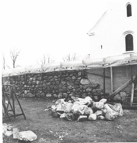
Kampestensmuren (under reparation) på vestsiden af Malling kirkegård.
