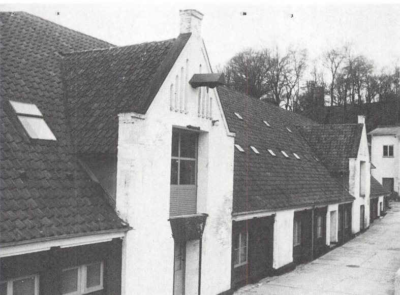
Forsiden af kreaturstalden er forsynet med to sidegavle, hvor det var muligt at læsse hø og halm ind på loftet. I stueetagen blev staldvinduerne udskiftet med større vinduer, da der sidst i 1930'erne blev indrettet kontor. Billedet er taget i 1954. (Foto i Erhvervsarkivet).
