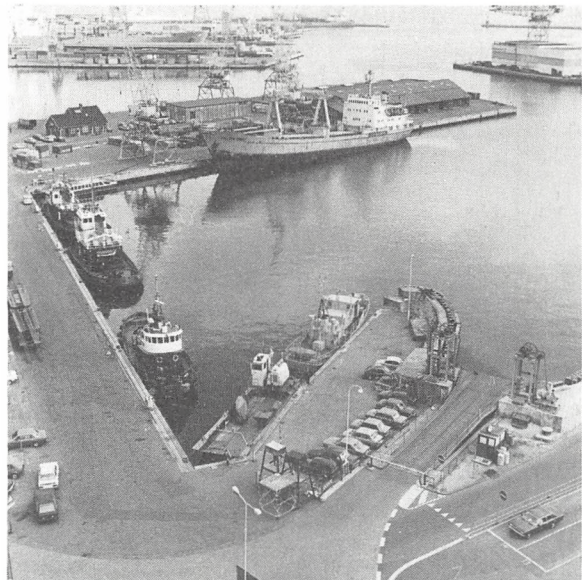
Det er dette bassin, der skal fyldes op, hvis de nye storfærger opnår tilstrækkelig succes. Her vil der så blive lavet særlige opmarchområder for biler og førerløse trailere.
