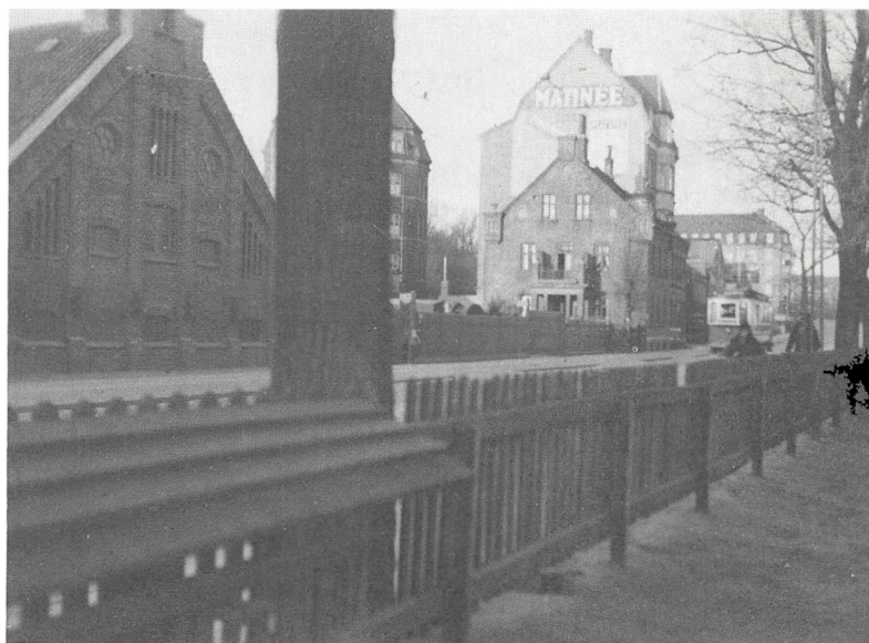
Kreaturstalden bevarede sit oprindelige udseende med de karakteristiske smedejerns staldvinduer til op i 1940'erne, ligesom gavlen stod i ubehandlede røde mursten. (Foto: Aage Fredslund Andersen).
