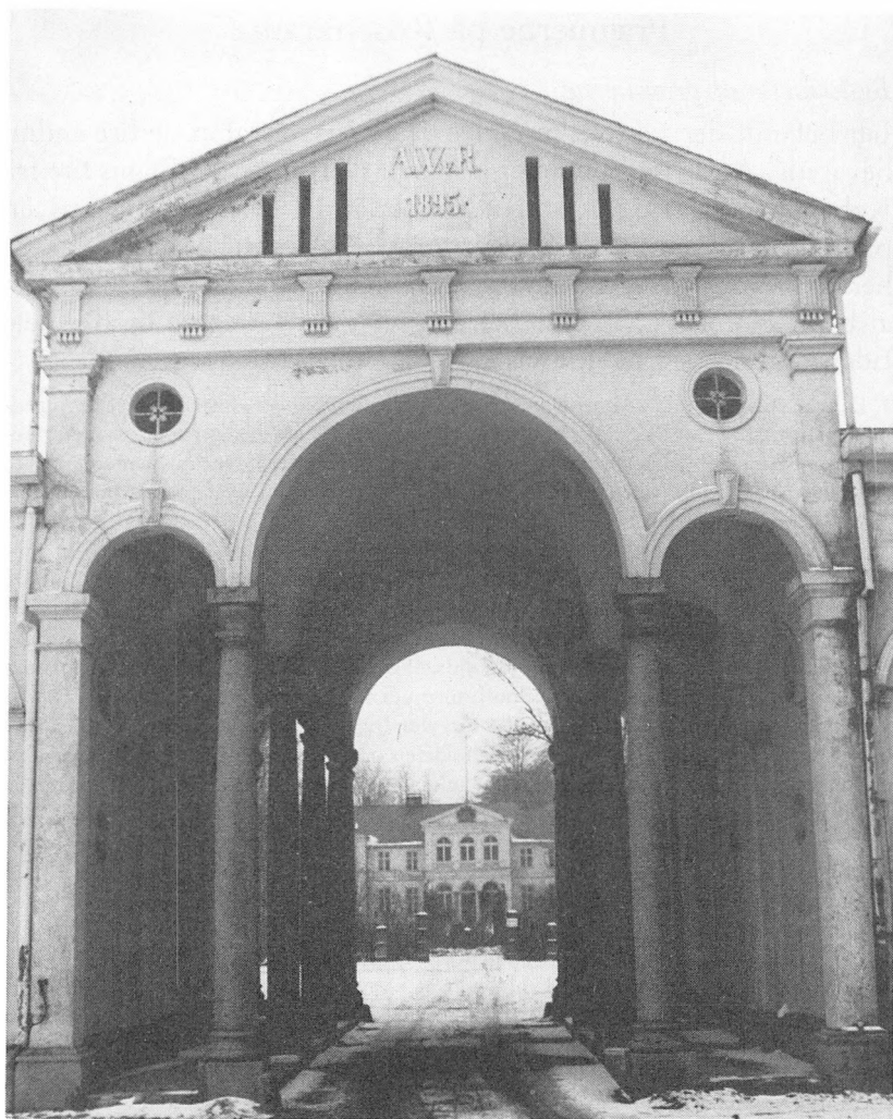
Fig. 5. Indkørslen til godset Rosenkrantz, hvis hovedbygning, opført 1791 og stærkt ombygget i 1890'erne, ses i baggrunden. Porthuset er opført 1895 af Axel Weber v. Rosenkrantz og bæres af otte slanke søjler afdækket med en lav trekantsfronton. I 1895 blev tillige de gamle stalde, der husede Dr. Webers ædle heste, nedrevet og istedet opførtes nye stalde på hver side af porthuset og sammenbygget med dette. (Foto af Liselotte Riis).
