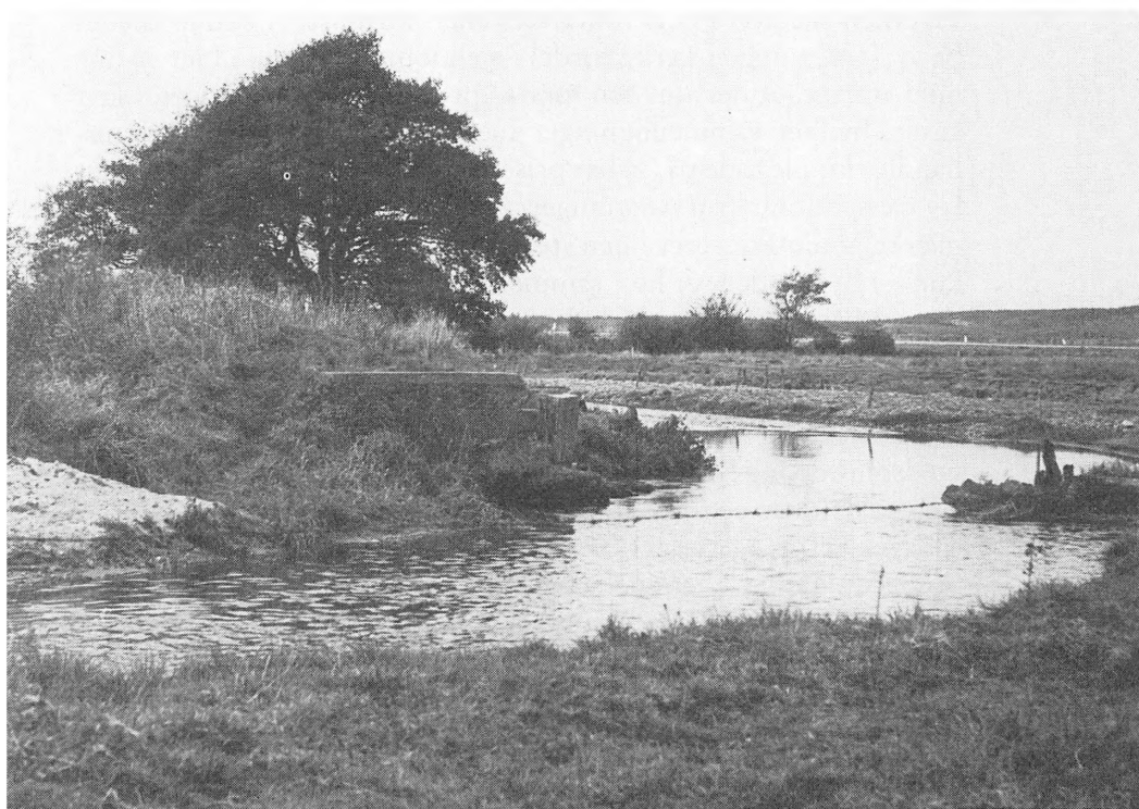
Rester af den sprængte Aarup sluse. – Når skytterne i slusen var sat, steg vandet i Fladså og trådte ind Kaltofts vandingskanal, der anes bag den hvide grusbunke til venstre i billedet.
