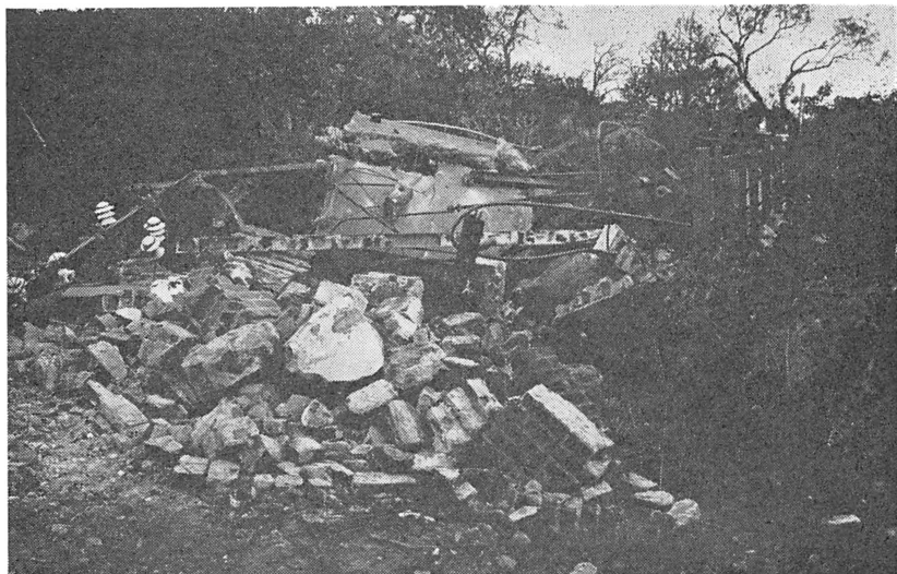
Resultatet af sabotagen mod transformatorårnet i Stollig natten til den 15. okt. 1943.
