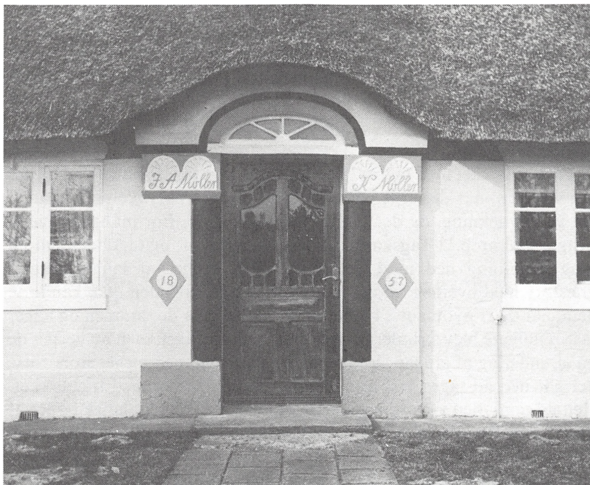
Portal og indgangsdør til matr. nr. 44 Kongsmark.
