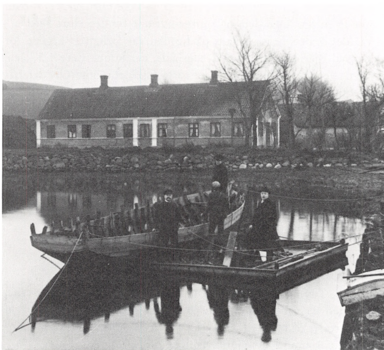
Kvasen »Newskys Minde« under ophugning ca. 1915. Den firkantede pram er understellet til muddermaskinen. Foto af C. Christensen, Viborg. Lokalhistorisk Arkiv for Viborg Kommune.
