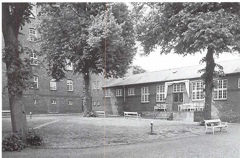
Afdeling F, den lave bygning til højre i billedet. Bygget i 1877-90, som den nordligste afdeling på området. Bemærk de højsiddende vinduer og gården med »Høje C« til venstre. Omkring 1950 (Lokalhistorisk arkiv, Viborg).
