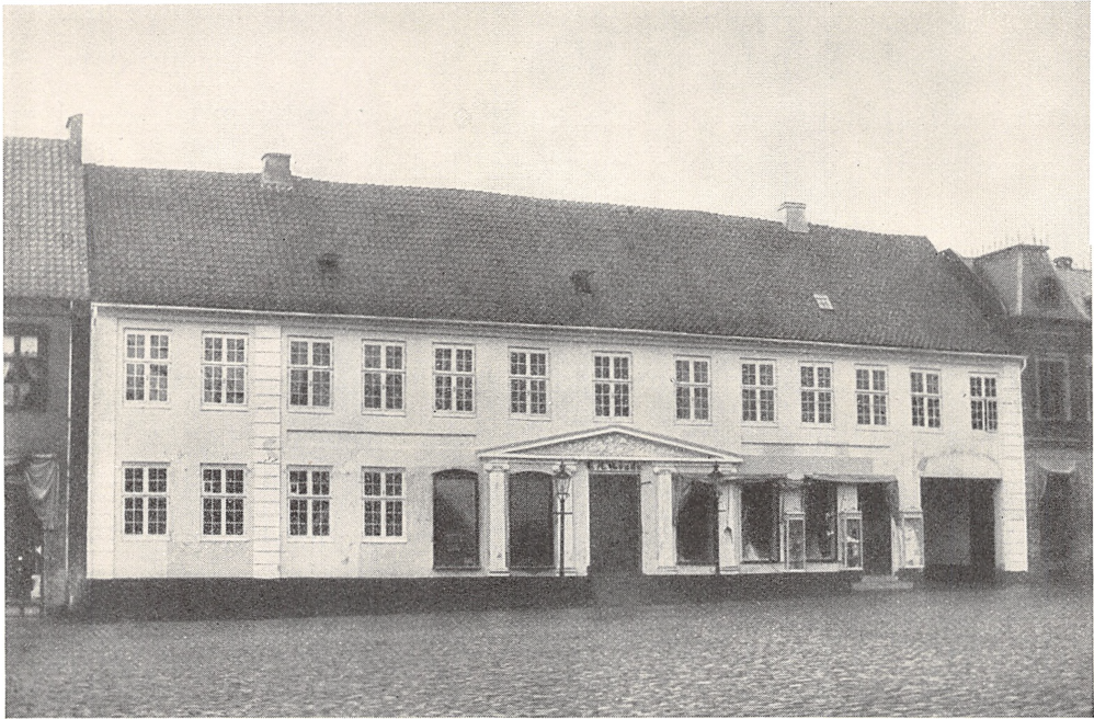
FORRETNINGSEJENDOMMEN CA. 1908 med Manufakturbutikken til højre og Kolonialbutikken til venstre for Indgangen
