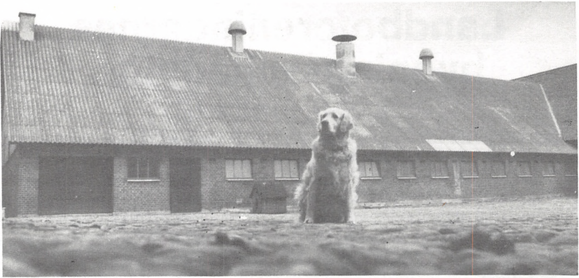
Staldbygning fra 1950'erne.
