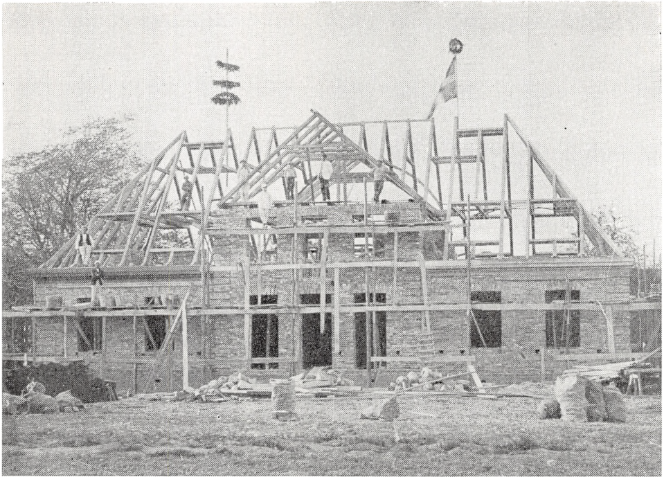
Tagkonstruktionen på Højbygårds nye stuehus er rejst, fejret med kransejsning og et gilde. Det er håndværkernes fest, og de er med på fotografiet. De mange skikkelser angiver for øvrigt størrelsesforholdene i tagkonstruktionen. Tømmerarbejdet på Højbygård (Framlev sogn, Århus amt) blev udført i sommeren 1920 af tømmermester Krog fra Harlev. (Fot. tilh. tømmermester Krog).
