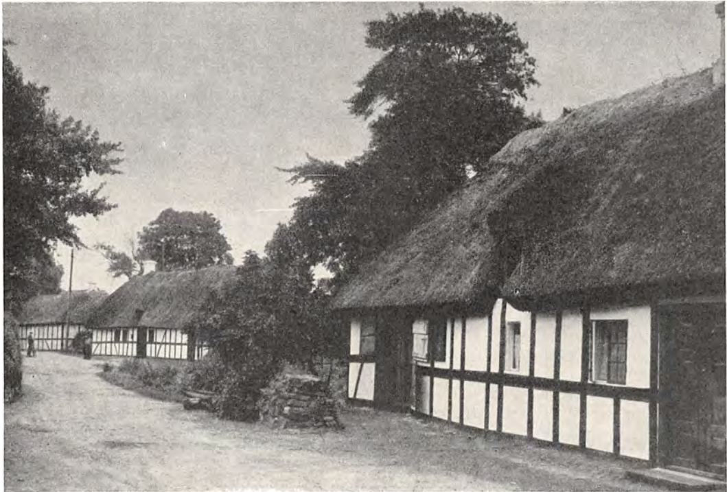
Landsbygaden. Herluf Lykke fot.
