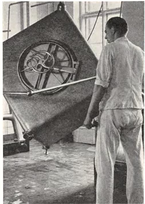
Tilvenstre: Moderne dansk skumfri Trykcentrifuge. — Tilhøjre: En Kubus-Kærneælder af rustfrit Staal
