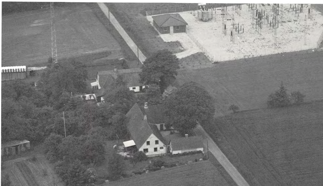
Bebyggelserne Åbovej 13 og 15 set fra øst. På den anden side Åbovej Sydsjællands Elektricitetsværks transformatorstation. Luftfoto 1983.
