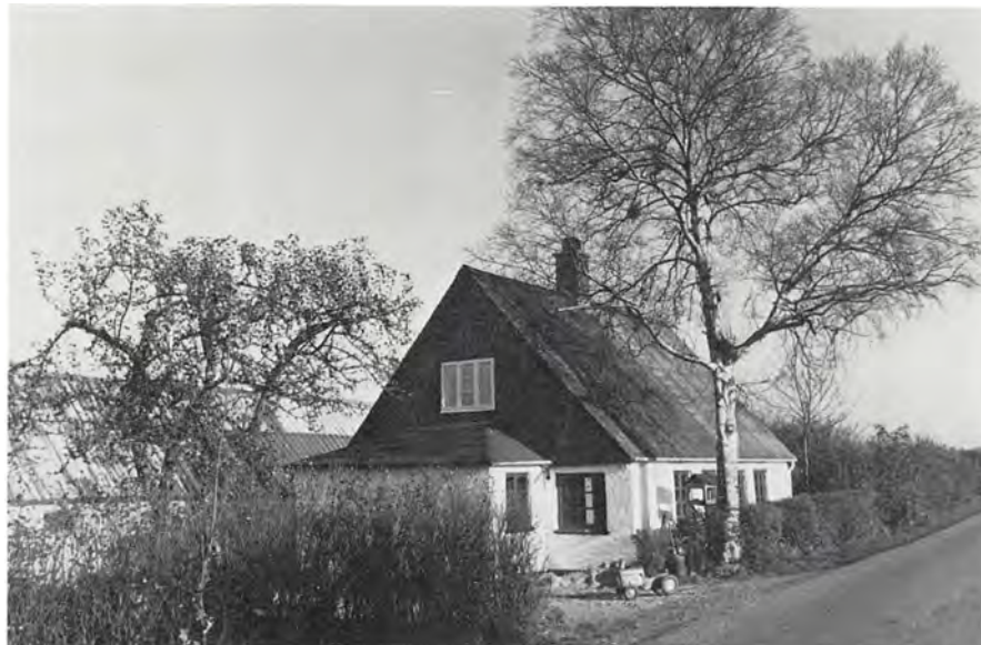
Facaden mod Herlufsillevvej. 1982.
