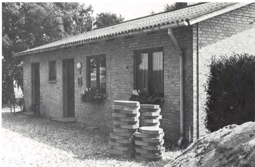
Nybygning efter branden i 1961. Fotograferet 1983.
