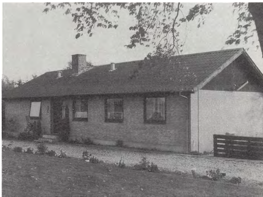
År for år fornyes landsbyernes bygninger, nogle helt i stil med byernes nyere parcel- og typehusbyggeri. (Her et eksempel fra Åbovej 9).
