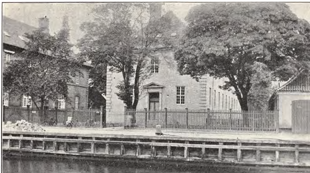
Frederiksholms Kanal Nr. 23—27. I Midten Inspektoratet for Tobaksbeskatningens nye Bygning.
