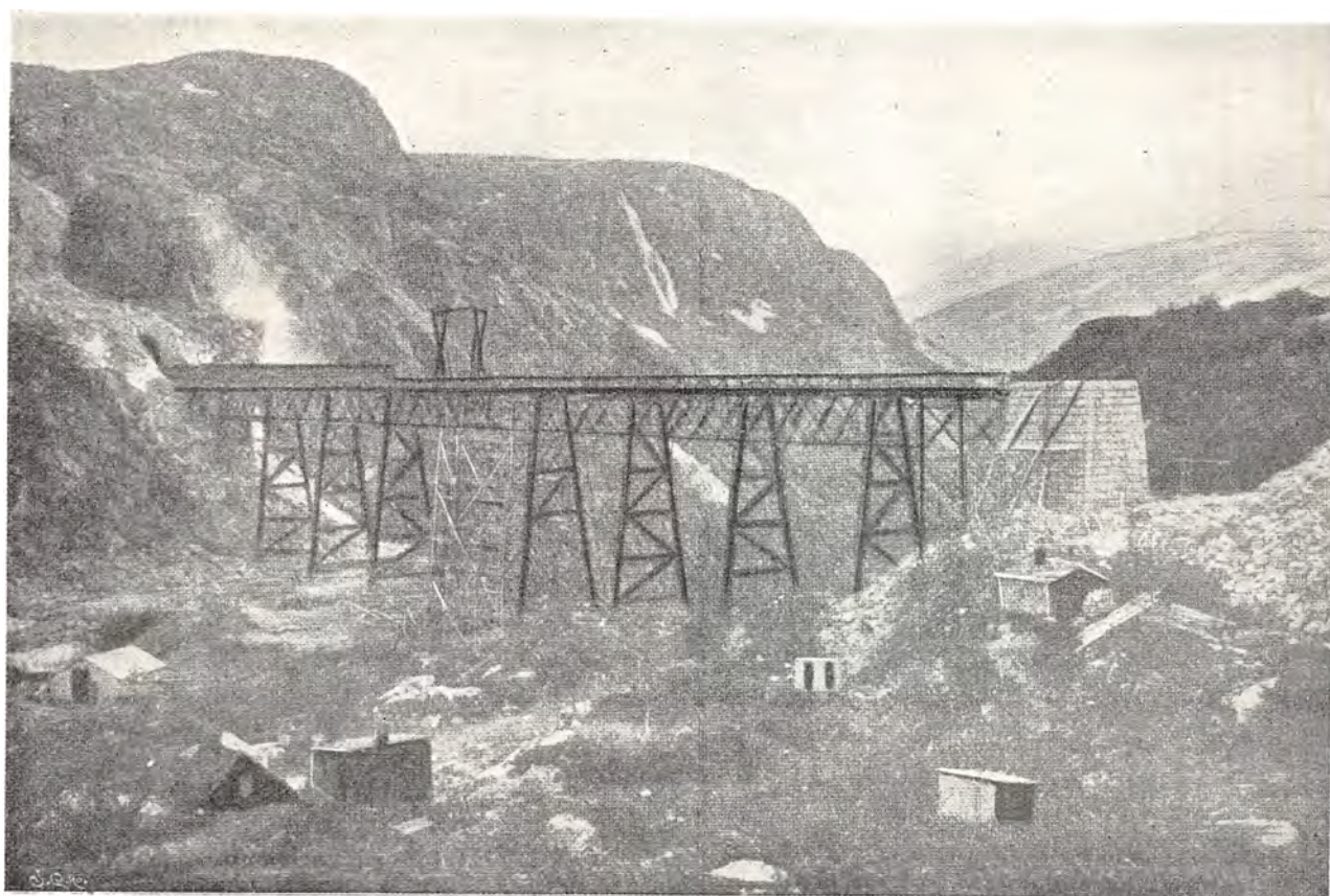
66. BROEN VED NORDDALSSENDEN UNDER MONTERING 1902
