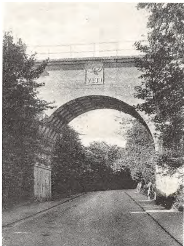
220. VIADUKT LEMVIG HAVNEBANE 1921
