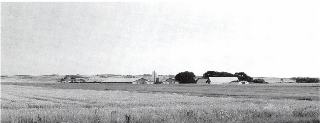
Større produktionsanlæg til kyllinger flot placeret i landskabet og i forhold til den bestående gård. Foto: Landbrugets Rådgivningscenter.
