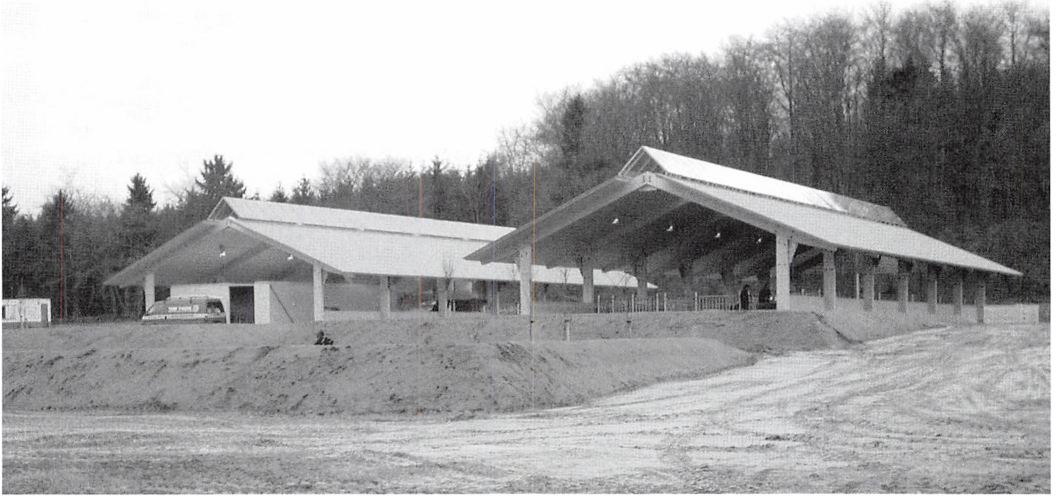
Nyudviklede stalde af massive træelementer. Foto: Landbrugets Rådgivningscenter.
