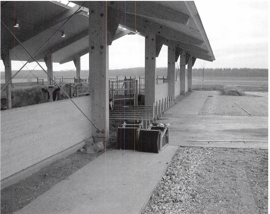
Nyudviklede stalde af massive træelementer. Foto: Landbrugets Rådgivningscenter.
