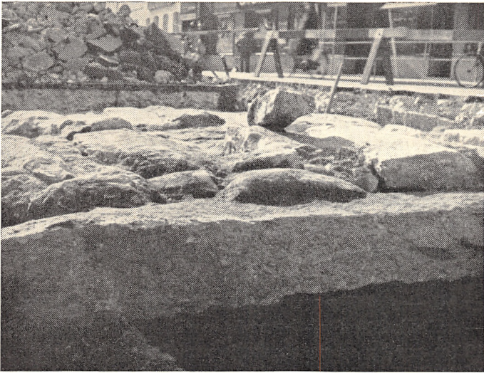
Maren Brandts bro under udgravning. Forrest en granitbjælke på tværs af åen, bærende de kortere tværliggende sten i kørebanen.
