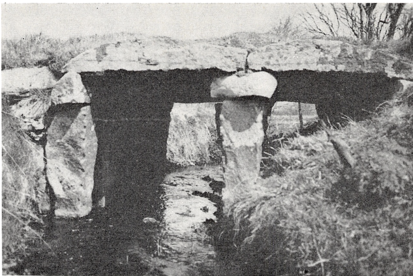
Svingelbro i Mosbæk under den gamle Nibe-Hobro landevej.
