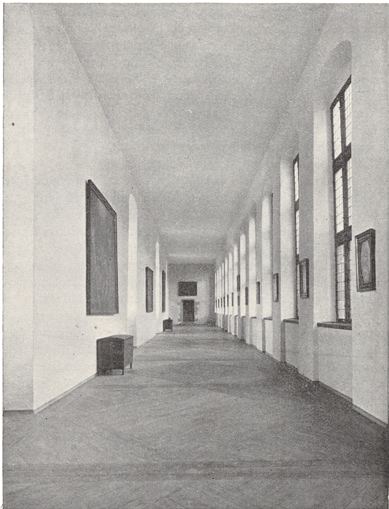
7. GALLERIET I ØSTFLØJENS ØVERSTE ETAGE EFTER RESTAURERINGEN
