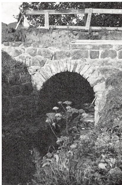
Skæremølle-bro ved Langstrup å på vejen mellem Langstrup og Lønholt er en af landets ældste broer. Den er antagelig bygget i tiden omkring år 1600. Forf. foto.
