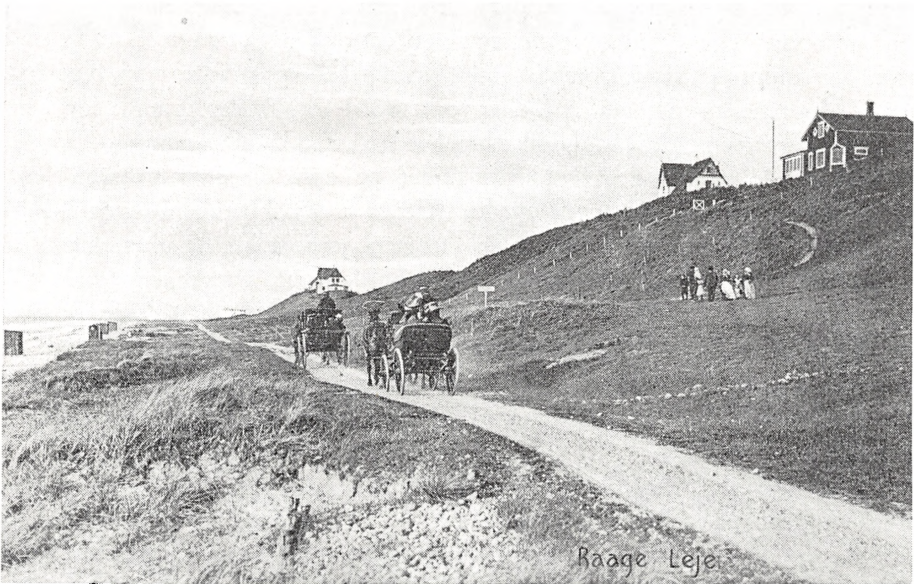
I slutningen af forrige århundrede begyndte sommerhusbyggeriet at tage fart. Nye veje måtte anlægges, og mange gamle veje, der ikke var stort andet end hjulspor, blev »grundforbedret« og fik kørebaner af skærver. – Kystvejen ved Rågeleje. Postkort fra omkring år 1900.
