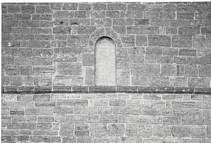
Fig. 8. Vejby. Nordsiden af skibet. Det østligste af de tilmurede romanske vinduer, der står direkte på kordongesimsen. Til venstre for vinduet ses en lodret fortdanding, der markerer et byggestop.
