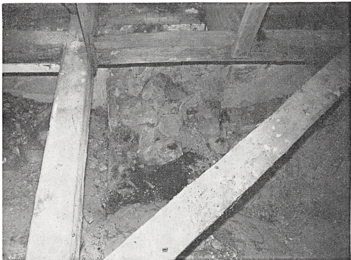
Fig. 3. Vejby. Over hvælvingerne. I hvælvlommen mellem 5. og 6. hvælving, regnet fra øst, ses på nordmuren, under de vandretliggende loftsbjælker (bindbjælker) et bevaret stykke af det romanske tårns østmur. Foto: JJF 1978
