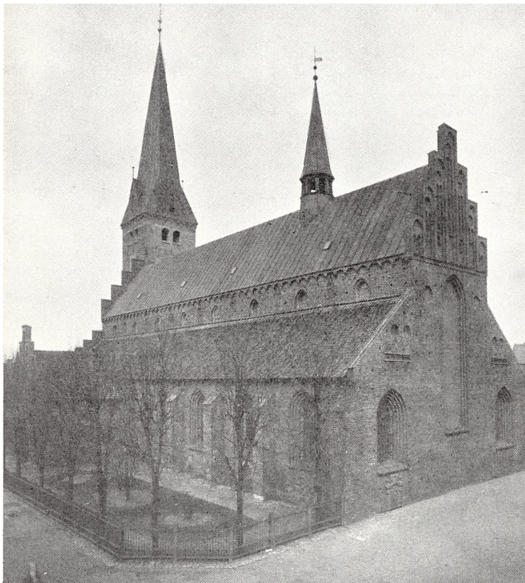
St. Olavs sydside og østgavl 1898, fotograferet umiddelbart efter opsætningen af det nuværende spir. Gavlen har smukke kamtakker og blændinger. Det store østvindue, bag hvilket altertavlen står, er tilmuret. Langs søndre sideskibsmur står en række støttepiller; mellem disse ses flere gravkældervinduer. I fag 2 skimtes den i teksten omtalte sandstensportal. – Foto, optaget på foranledning af tømrerm. Wilh. Unmack, der opførte spiret; skænket til Helsingør Bymuseum af overlæge C. U. Jessen, Helsingør.
