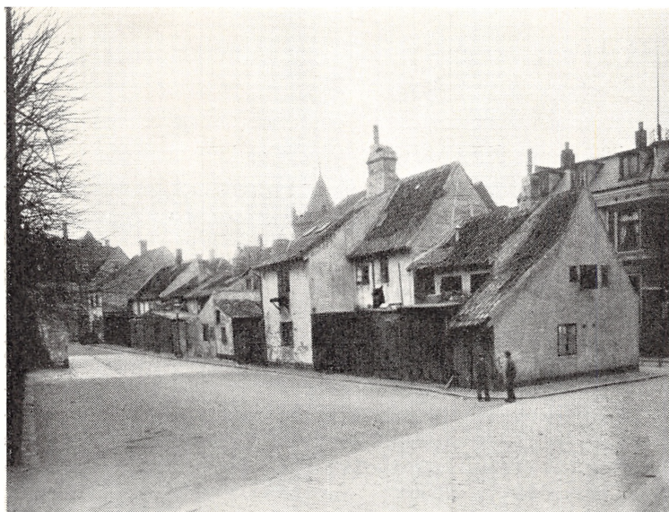
Småboderne langs St. Annagade foran kirkens vestside, med bagsiderne ind mod kirkepladsen, set fra St. Olaigade ca. 1900. Omkr. 1910–15 blev flere af disse huse nedrevet, så kun Buxtehudes hus, længst i baggrunden, og dettes nabohus endnu står. Den lave, beskedne bebyggelse giver en mægtig kontrast til kirkebygningen, der derved får en overvældende og majestætisk rejsning. – Foto i Helsingør Bymuseum.
