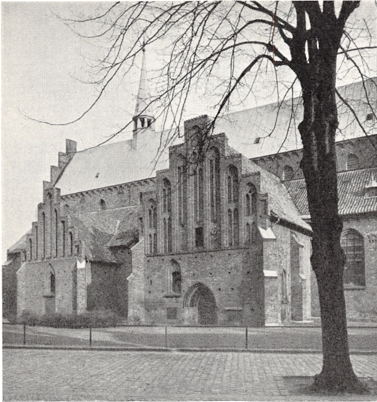
Blik fra St. Olaigade mod kirkens nordside med udbygninger, t. v. sakristiet, t. h. trefoldighedskapellet eller Oxernes kapel, begge med pragtfulde blændingsgavle. Trefoldighedskapellet er en statelig bygning i to etager fra ca. 1450, med en smukt profileret portal, som egentlig er den gamle kvindeindgang. Mens sideskibenes og udbygningernes tag er af tegl, er højskibstaget og tagrytteren af kobber. – Fot. H. Hauch.
