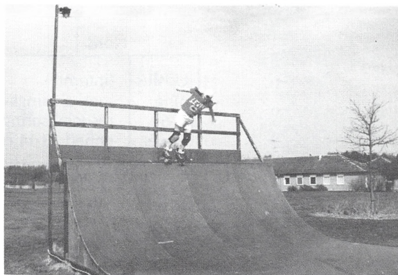
Snedkerværkstedet forestod udfærdigelsen af den ultramoderne skate-board-bane, som er et væsentligt aktiv i elevernes og deres kammeraters fritid.
