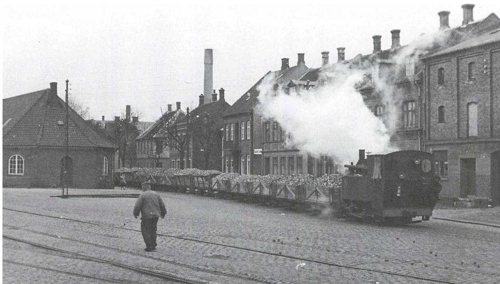
Havnegade i Nakskov ca. 1935. Gaden var fyldt med spor til roetogene til og fra sukkerfabrikken. Nakskov Lokalhistoriske Arkiv.
