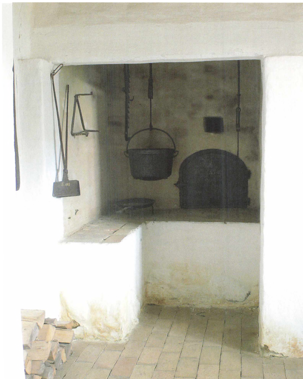
I køkkener som dette har man lavet de retter, der omtales i artiklen. Den murede ildbænk inde i selve skorstenen gav god mulighed for at arbejde med gryderne over ilden i en behagelig højde. Bagerst i skorstenen ses ovnen. Dette er køkkenet fra Reventlows skole fra Langet på Lolland opført 1817. Bygningen står nu på Frilandsmuseet i Maribo. Foto forfatteren september 2008.
