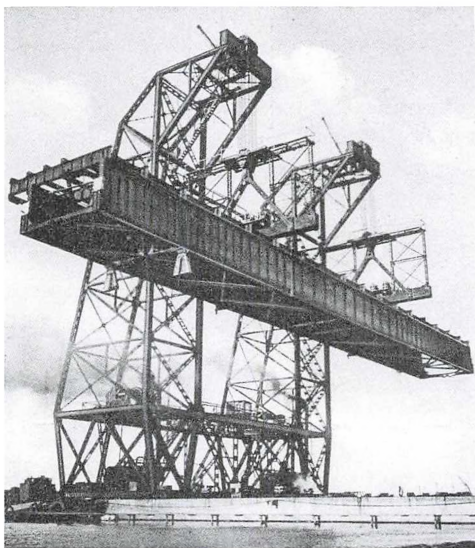
Verdens største flydekran, Stærkoder, transporteret et brofag i ca. 1937. Lokalhistorisk Arkiv for Nordfalster.
