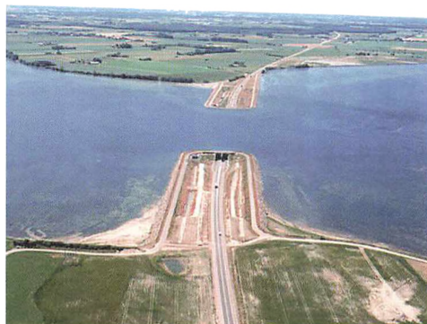
Guldborgsundtunnelen. Foto: Vejdirektoratet.
