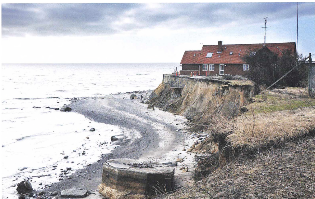
Marinestationens gamle bygning nedrives. Foto: Folketidende, Anders Knudsen.
