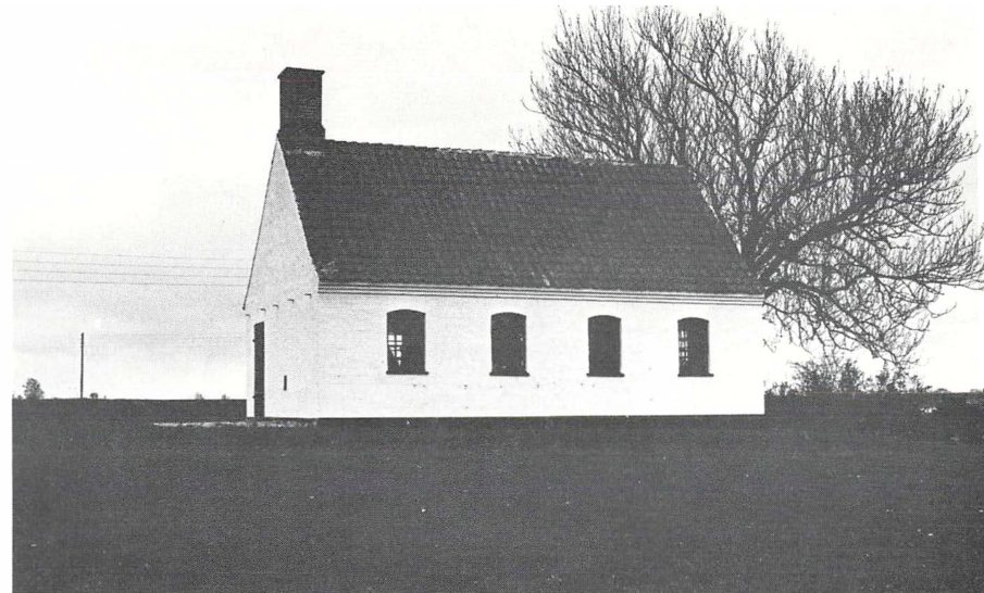
Bygningens bagside mod nord
