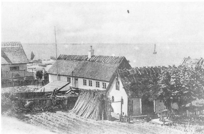
Cornelius Corneliussens hus. I forgrunden »Sommergården«, der får taget repareret. 1922.
