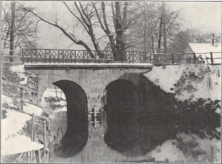
Broen over Kanalen ved Arresødal.
