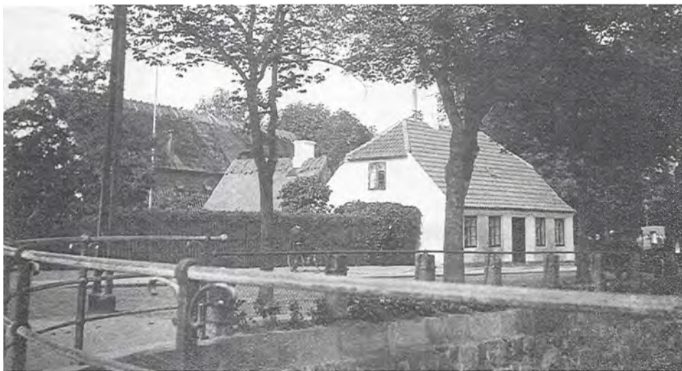
Stuehuset, som Peter Lund opførte i 1847, lå ud til Lyngby Hovedgade ud for Nordre Mølle, der ses til venstre. Huset blev revet ned ca. 1940. Foto ca. 1920. Byhistorisk Samling
