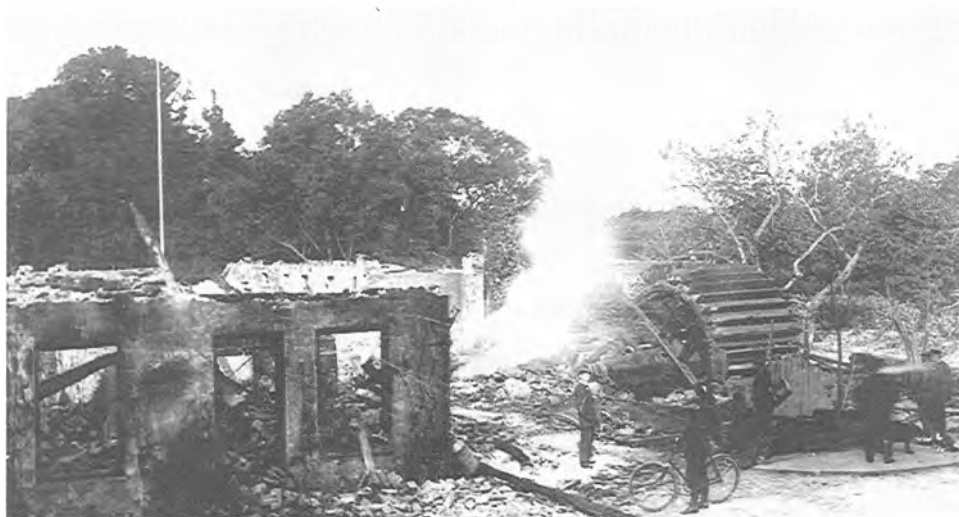
Lyngby Søndre Mølle dagen efter branden, d.v.s. den 30. juli 1902. I forgrunden til venstre resterne af Lyngby Hovedgade 26. Til højre ses vandhjulet, som var det eneste, der blev tilbage af møllen. Underfaldshjulet på den gamle Søndre Mølle var mindre i diameter, men bredere end brystfaldshjulet på Nordre Mølle. Byhistorisk Samling
