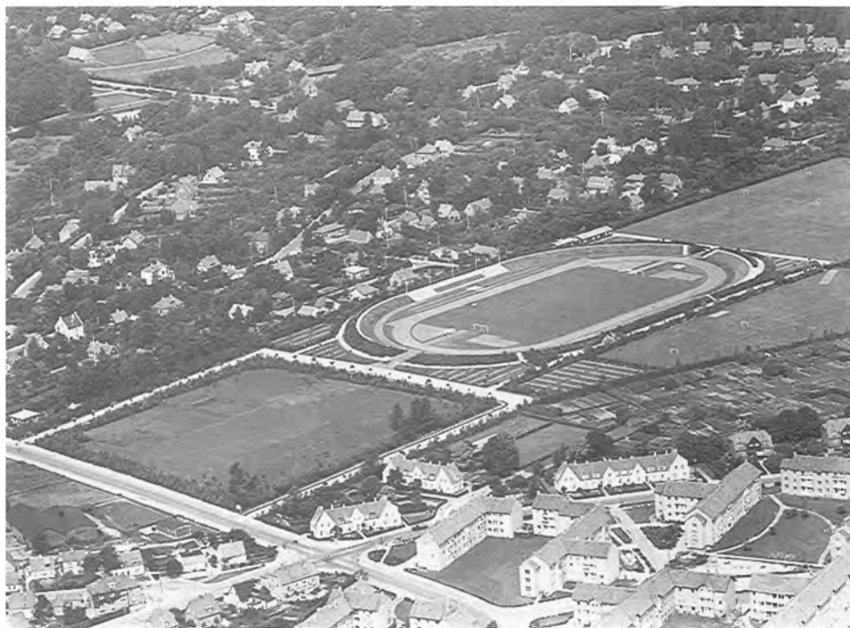
Lyngby Stadion var i begyndelsen ret primitivt i forhold til i dag, og adgangsvejene anderledes (luftfoto ca. 1950). Øverst bueskytterne og de kvindelige roere ved indvielsen.
