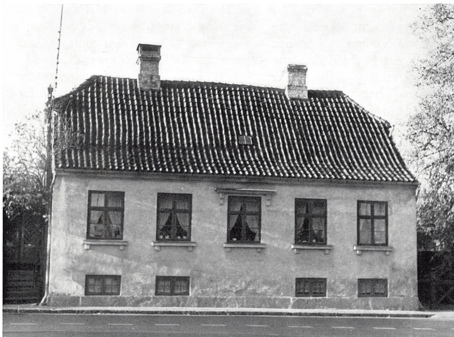
Lappen nr. 1. Trappen er fjernet og døren erstattet af et vindue. Fotografi i Helsingør byhistoriske Arkiv.
