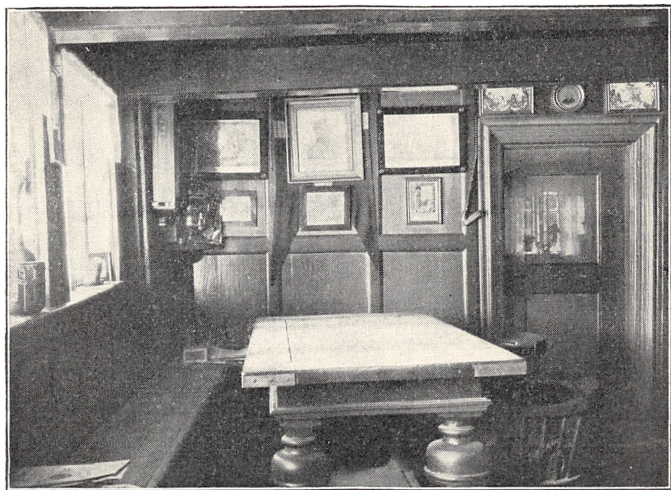
Fogedgaarden. V. Dagligstue. Venstre Side.
