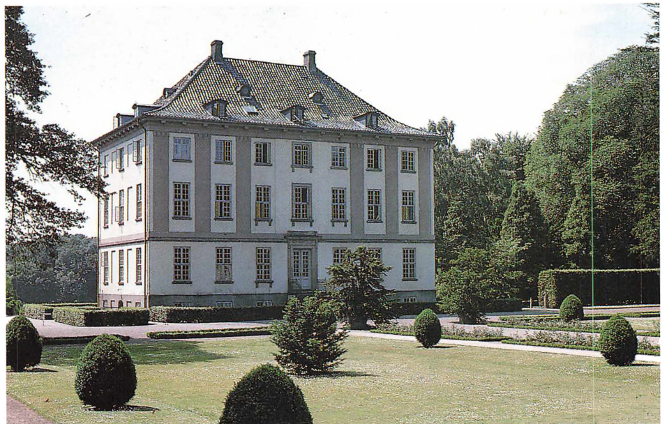
Hovedbygningens nordfacade ca. 1970. I forbindelse med en restaurering havde man valgt at fremhæve lisenerne med en farve, der svarede til facadens vandrette sandstenselementer. Foto, forf.
