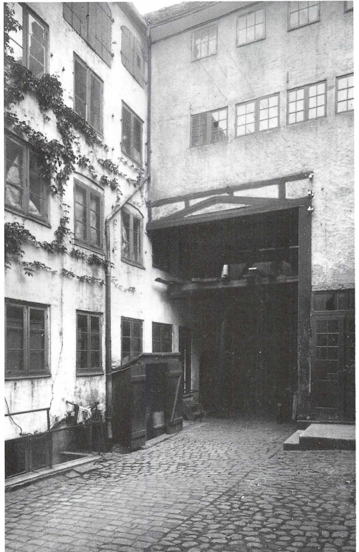
Et enkelt ældre fotografi af Christen Jeppesens og Wiibroes gamle bryggeri giver et indtryk af atmosfæren i den snævre gård. Til venstre i billedet ses bryggeriet med nedgang til kælderen, og øverst de endnu bevarede luger ind til kornloftet. Over den største luge sad hejsekvisten. Til højre i billedet ses baghuset, hvor Carl Wiibroe indrettede sin nye malkølle. Helt til højre ses et åbent vindue i sidebygningen til naboejendommen Stengade 80, som Wiibroe senere købte. Både baghus og sidebygningen til højre er idag nedrevet. Helsingør Kommunes Museer.
