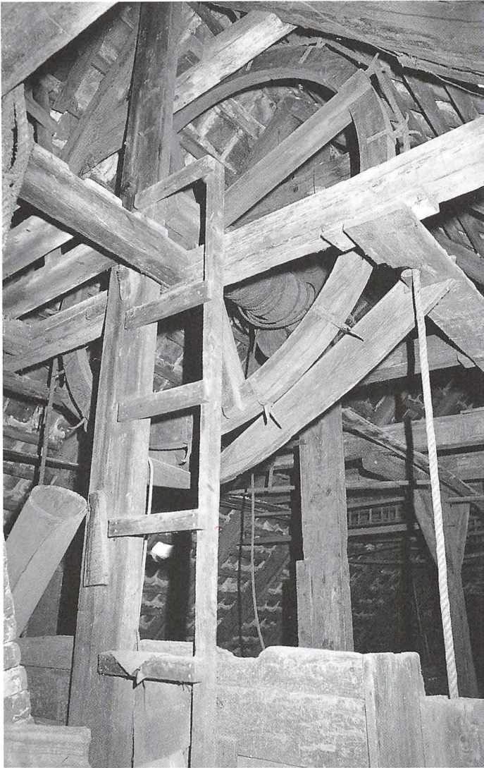
Indtil 1978 kunne man finde spor af Christen Jeppesens og Carl Wiibroes gamle bryggeri i Stengade 82. Her ser man det velbevarede store træhjul til hejseværket mellem etagerne. Ved omdannelsen af bygningen til ejerlejligheder blev fortidens spor totalt udslettet. Foto af Carsten Møller, 1978. Helsingør Kommunes Museer.
