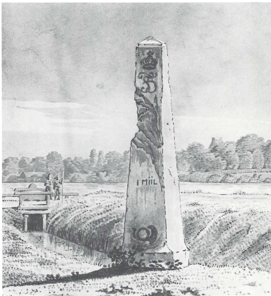
Helmilestenene langs vejen var hugget i norsk mamor af hofstenhugger J. P. Pfeiffer. Materialet var lidet modstandsdygtigt, og stenene forvitrede hurtigt. Tegning: Martin Rørbye.
