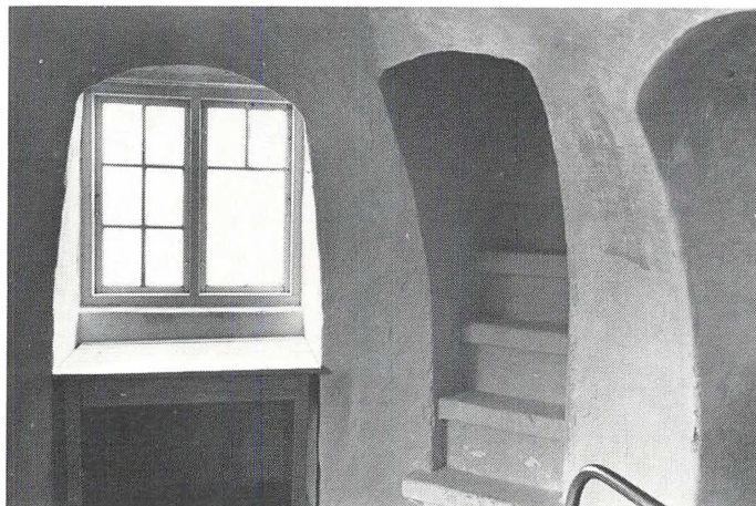
Gammelt lamperum i øverste stokværk i det nedlagte østlige fyr på Nakkehoved. Den mystiske trappe, der ender plat i muren, er en af fire tilmurede løngange op til platformen med åbent blus. Herved kunne fyrapersonalet altid komme op i vindsiden.
