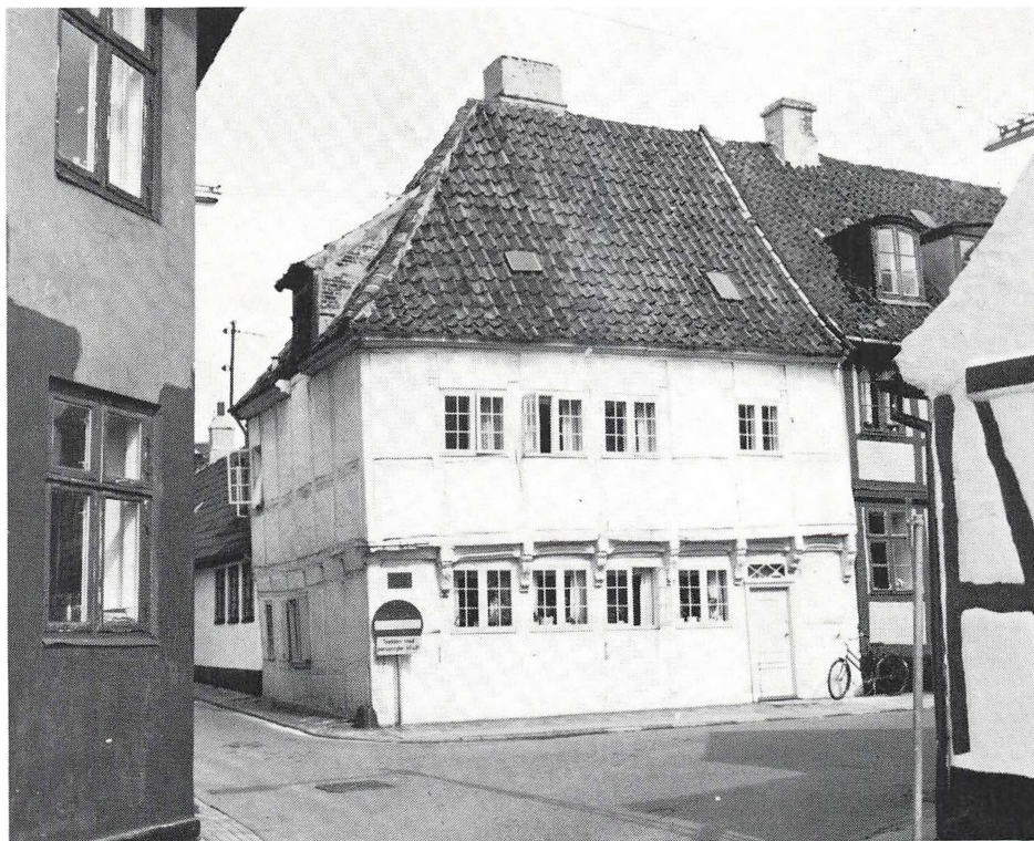
Strandgade 27. Det udskårne årstal 1577 til højre for dørfaget gør huset til det ældste daterede bindingsværkshus i byen. Husets øvre stokværk udkrager mod Strandgade. Foto i Helsingør Bymuseum.
