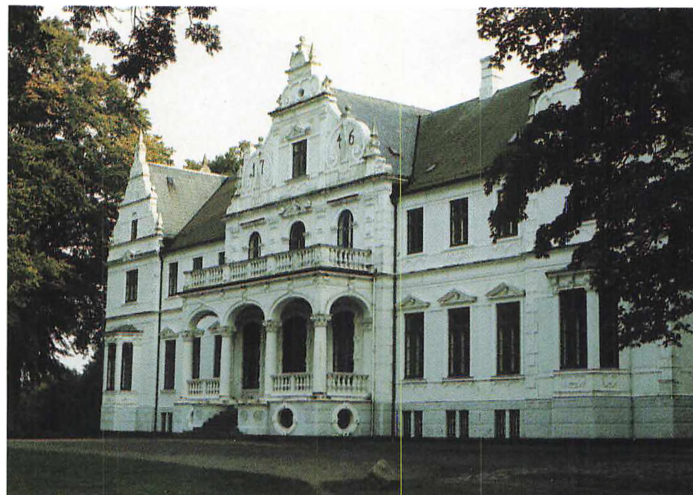
Kokkedals nordfacade med hovedindgangen, der markeres af fire korintiske søjler. Over disse en altan med en storslået udsigt langt mod nord. Foto 1988.
