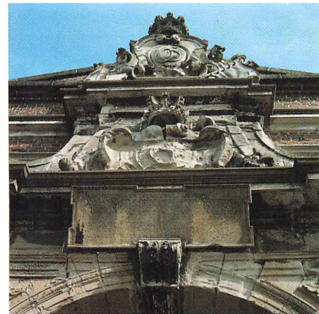
Lige over »Kronværksporten« sidder tavlen med Kingos storladne vers »Triin ind –«. Det er forvitret og trænger til restaurering.
