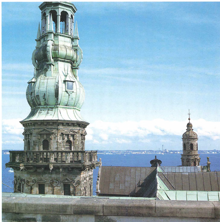
Sydfløjens tagryg set fra »Telegraftårnet«. Til højre Lambert van Havens »Kakkeborg«, helt i sandsten, fra cirka 1581. Til højre den nedre del af Hardorffs spir på »Trompetértårnet« med de elegante og overlegent sikre former. Det samme gælder tårnet af sandsten, med det fine sandstensarbejde, der – som i gotiske katedralers øvre partier – er skabt for luftens ånder. Vi mennesker kan knap se dem.
