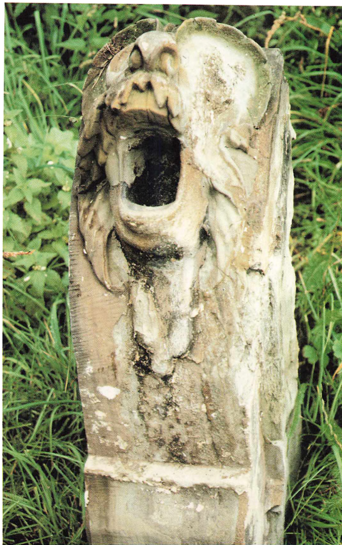
Nedtaget, stærkt forvitret vandspy fra Kronborgs østside, kaldet Manden med tangskægget . E.E. foto, 1976.
