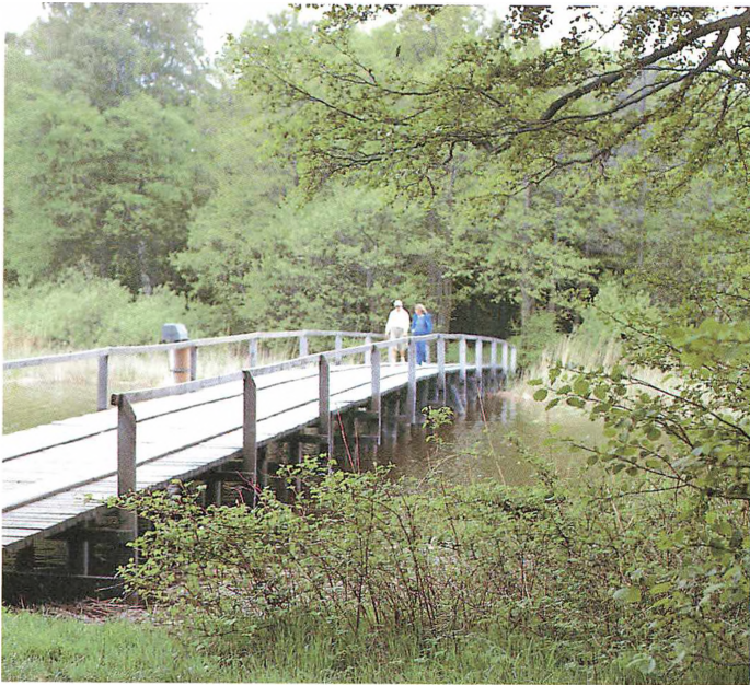
Broen over til Storø. Den blev etableret som led i en militær øvelse.
