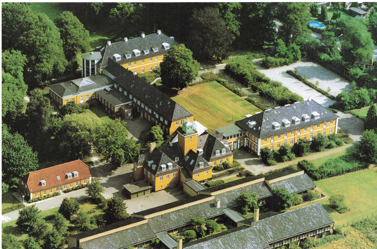
Luftfoto fra 1992 af Montebello. Foto: Arne Magnussen.
