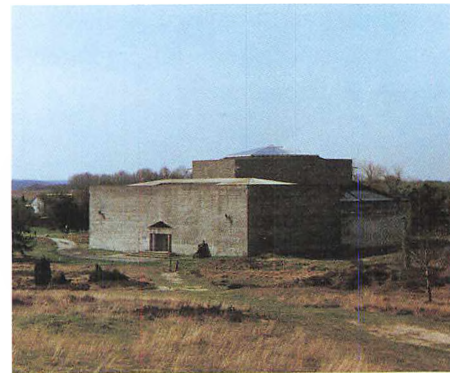
Tegnermuseet i Rusland, opført 1937-38. Den asketiske facades eneste udsmykning er indgangspartiet, flankeret af to nøgne søjler og kronet af en lige så nøgen trekantfronton.
