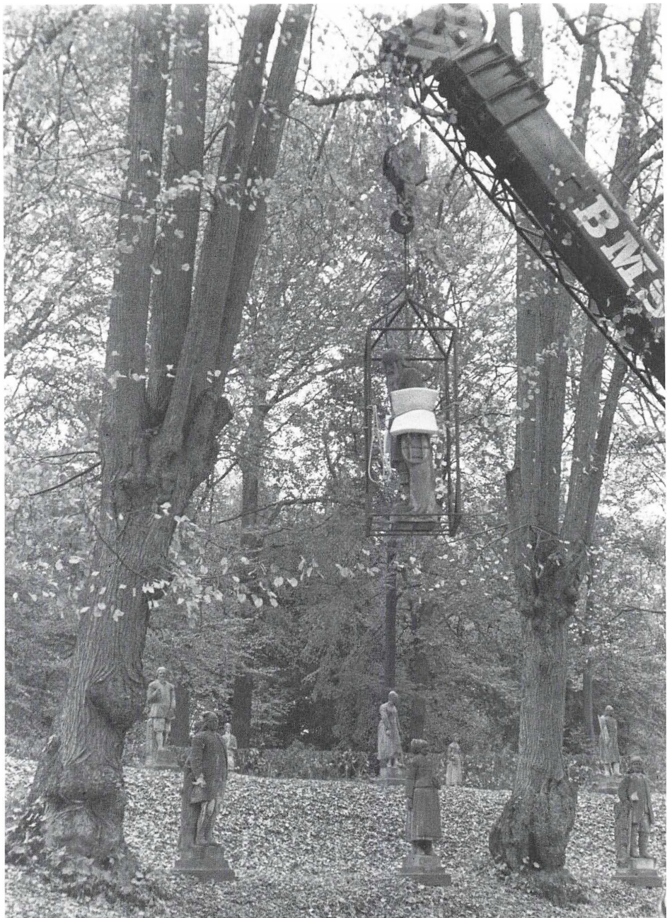
Allerede i 1978 førtes 28 af Nordmandsdalens figurer i sikkerhed til Lapidariet i Fredensborg. For at undgå at skade skulpturerne blev de løftet fra deres sokler fastspændt i en særlig burkonstruktion. Her er det »Manden fra Voss«, der forlader sin plads i anlægget. Foto: E.E.
