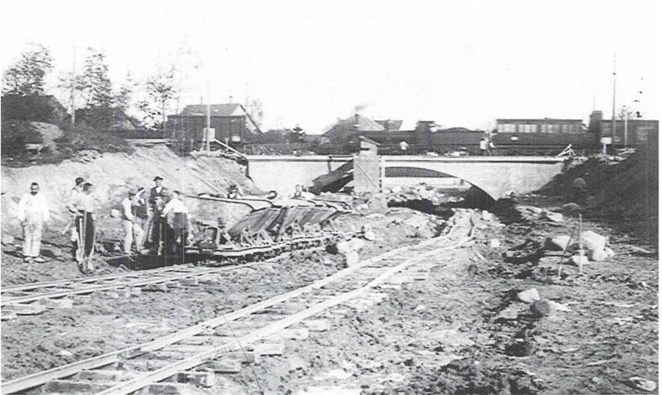
Scener fra anlægningen af Buddingevejs viadukt under jernbanen i 1920. Øverst sænkningen af Jernbanevej med Lyngby Station i baggrunden. Villaen til venstre, som kom til at ligge på hjørnet af Jernbanevej og Nordre Torvevej, tilhørte fotografen A. Th. Collin. Nederst ses den ufærdige Buddingevej med viadukten fra vest.
