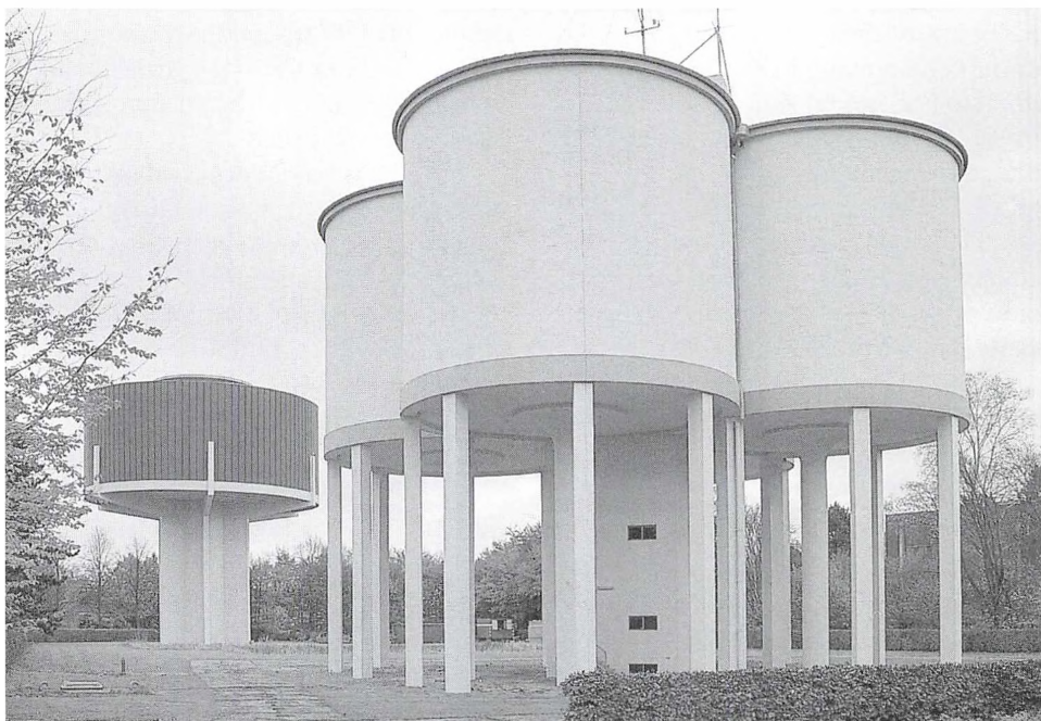
Vandtårnene på Baunehøj. Det forreste er bygget i 1941, er i alt 25 meter højt og rummer 3800 kubikmeter vand. Det bageste er fra 1973, har en samlet højde på 30 meter og rummer 2000 kubikmeter vand. Terrænet, som vandtårnene står på, ligger 48 meter over havet.
