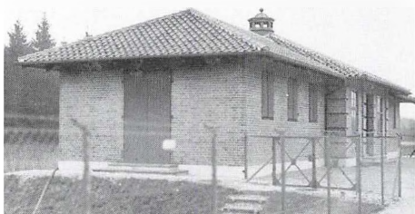
Dybendal vandværk, opført 1932.
