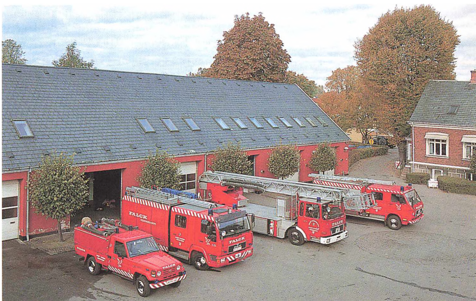
Lyngby Brandvæsens udrykningskøretøjer fotograferet i oktober 2003 fra en lånt drejestige. Fra venstre slangetenderen (2001), automobilsprøjte M1 (1998), drejestigen (1987) og M2 (1981). De to MAN-automobilsprøjter har 2000 liter/min. kombinerede høj- og lavtrykspumper fra Ruberg, 2000 liter vandtanke (M1 2600 liter) og 80 liter skumtanke samt hver 2 x 60 meter højtryksslange. Toyota-slangetenderen er forsynet med en 1500 liter/min. bærbar Tohatsu-sprøjte og 500 meter slange. Byhistorisk Samling
