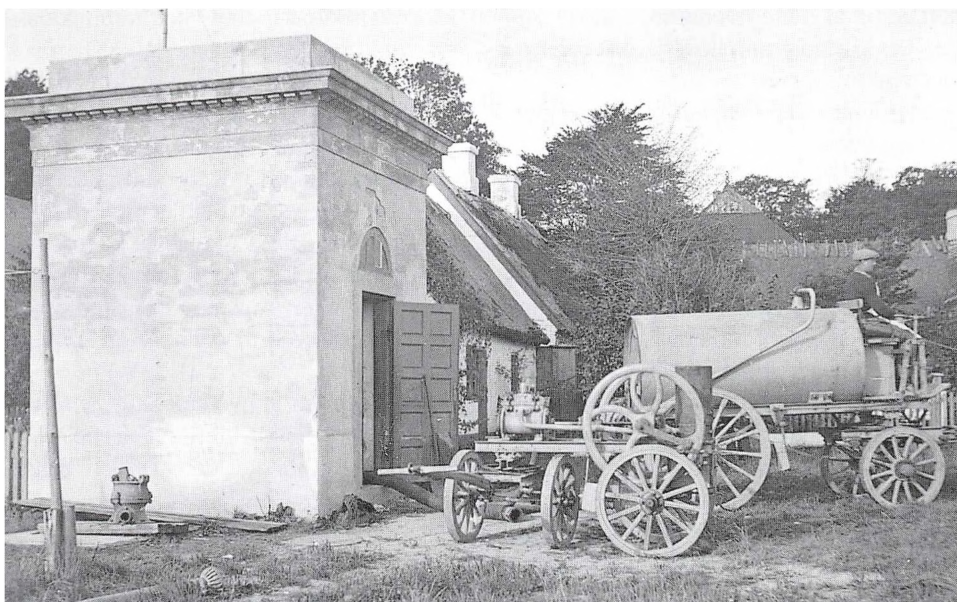
Pumpestationen i Taarbæk (opført 1918) og materiel til oppumpning af slam fra septictanke (anskaffet 1921). Husene i baggrunden er Taarbæk Strandvej 44 (t.v.) og 42, og i baggrunden skimtes toppen af koncertsalen på Klampenborg Badeanstalt. Byhistorisk Samling
