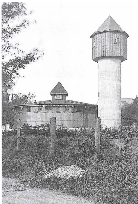
Vandtårnene ved Fortunen. Lyngby Vandværks første »vandtårn« fra 1904 stod direkte på jorden, og for at kunne få tryk på vandet i de omliggende huse opførtes i 1923 det lille zonevandtårn, som stadig kan ses ved Trongårdsvej.
