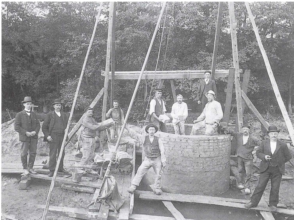
Den såkaldte samlebrønd under opmuring på Lyngby Vandværk i 1903 med Sorgenfri Slotspark i baggrunden. Yderst til venstre kommuneingeniør H. V. Rygner.
