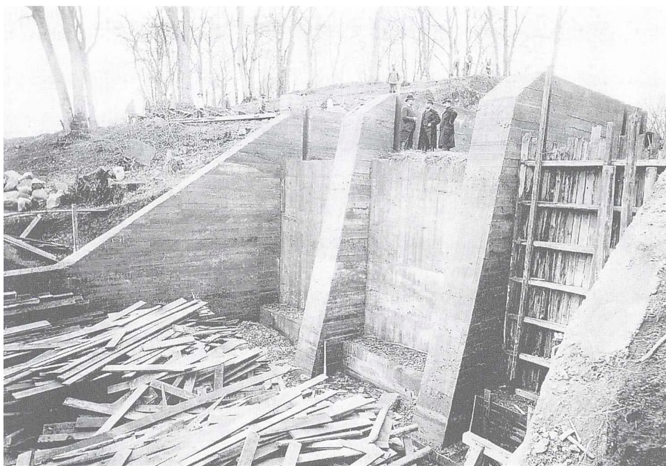
Dæmning I's stemmeværk og styrteseng i 1887.
