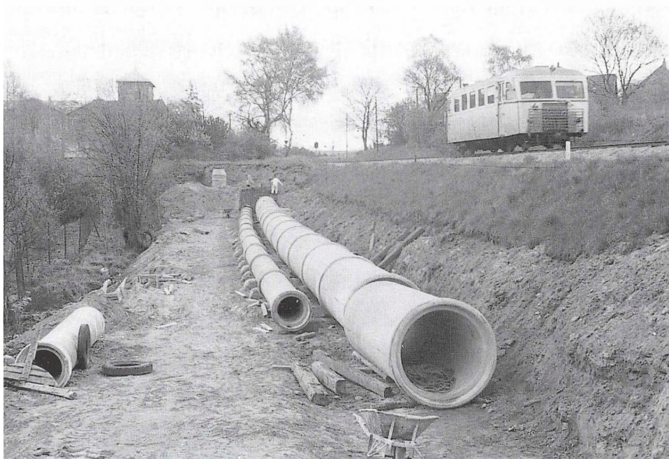
Lægning af afskærende kloakledning ved Ørholm Station i forbindelse med Mølleåplanen i 1950'erne.
