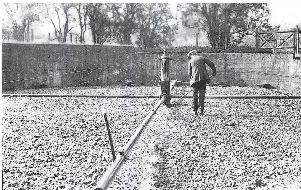
Filter med roterende sprinkler på det gamle renseanlæg i Bondebyen omkr. 1920. Beholderen er bevaret som regnvandsbassin. Byhistorisk Samling
