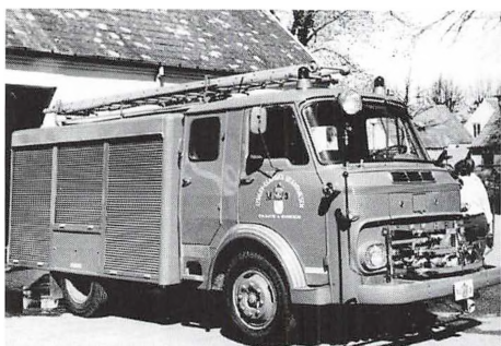
Commer-automobilsprøjte fra 1967. Denne såkaldte vagtsprøjte var et af Falcks standardkøretøjer, som blev fremstillet i mange eksemplarer. Vognen var udstyret med en 1600 liter/min. Ruberg frontpumpe og en vandtank på hele 3000 liter. For at nedbringe vægten var dele af vognen fremstillet af glasfiber, hvilket medførte dens øgenavn »Coca-Cola bilens«. Søren Rislunds arkiv
