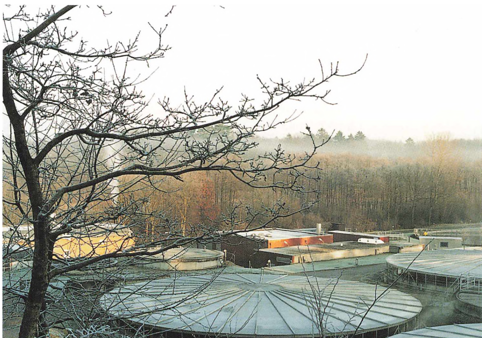
Overdækningen af tankene har formindsket lugtgenerne fra renseanlægget mærkbart, og stedets naturskønhed kan man heller ikke klage over.
