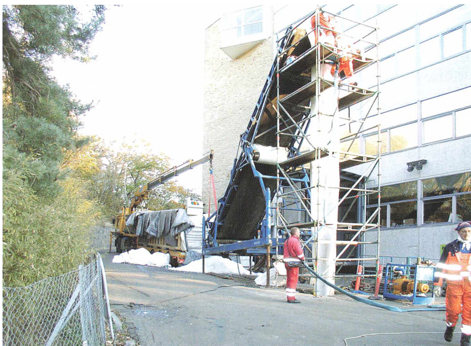
Strømpeføring af kloak, som det foregår i nutiden (jfr. side 106-07), bag ved ILVA på Gl. Lundtoftevej. »Strømpen« af glasfiberarmeret polyester sænkes fra stilladset ned gennem en kloakbrønd og anbringes i det underliggende kloakrør, hvorefter den hærdes. En fjernstyret boremaskine føres ind i røret og borer huller ud for tilledningerne. Strømpen på billedet er 400 m lang. Renseanlæg Lundtofte
